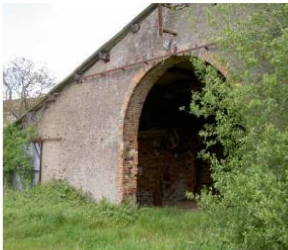
Cette grange de La Gauthrèche sera renouvelée en habitation.
