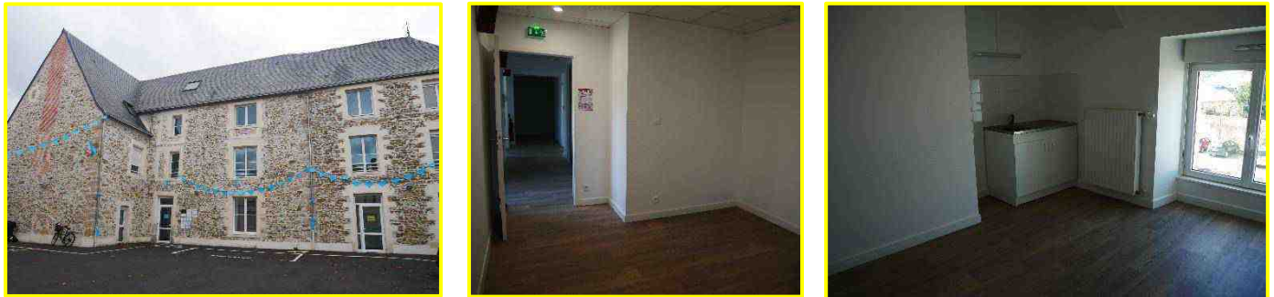
Images 5, 6 et 7 : prises de vue extérieures et intérieures des locaux
