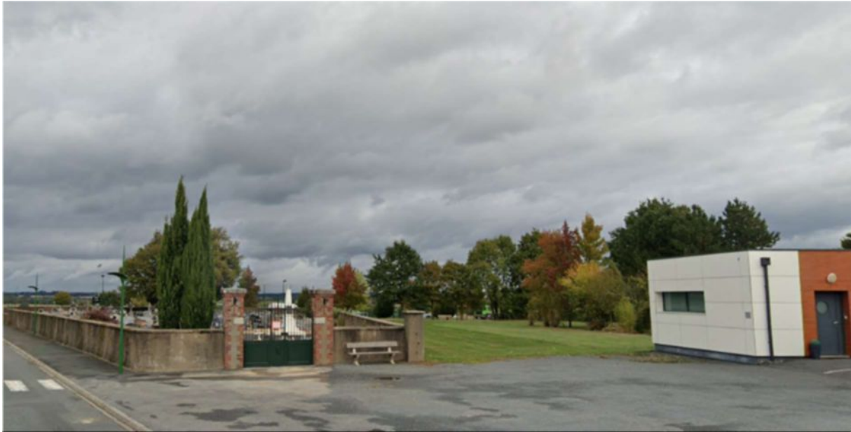
Cimetière et extension prévue (source Google Street View)
